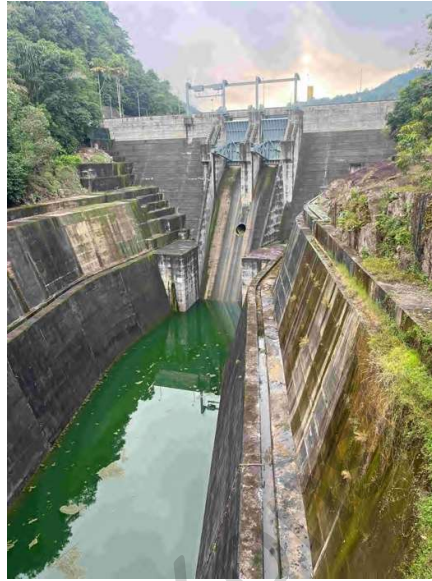
Foto 8: Bendungan Siguragura, bagian dari proyek Asahan-2, tanpa pelepasan aliran pemeliharaan
