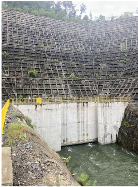
Foto 41: Pintu keluar terowongan Tailrace
