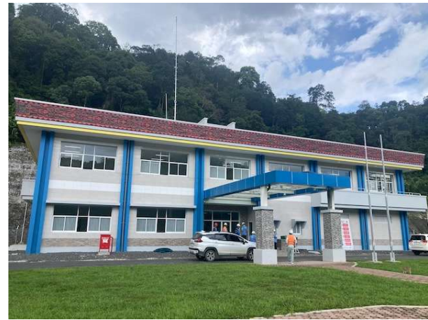
Foto 34: Gedung kendali dan administrasi PLTA Asahan-3
